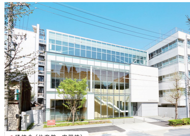
● 橘校舎 (体育館・実習棟)
